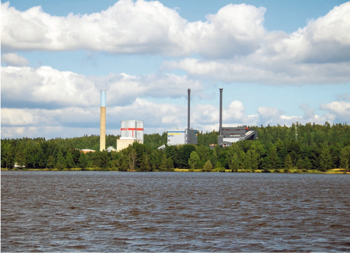
Växjö Energi Sandviksverket plant. Our supplier of electricity and district cooling in Växjö. Photo: Växjö Energi
